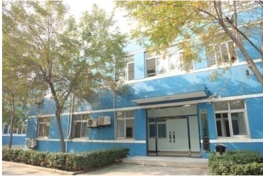
公司技术研发大楼
